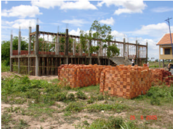
Baustelle im Juni 2005
