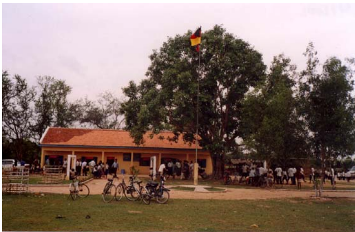
Gesamtansicht neues Schulgebäude
